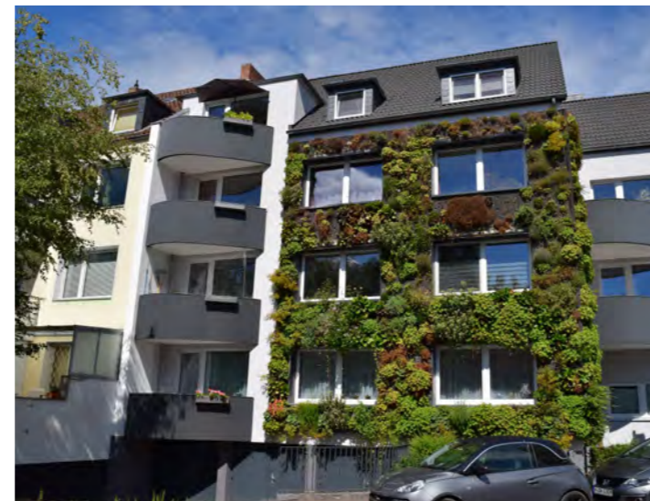
Wandgebundene Fassadenbegrünung vertikal. Quelle: BuGG
