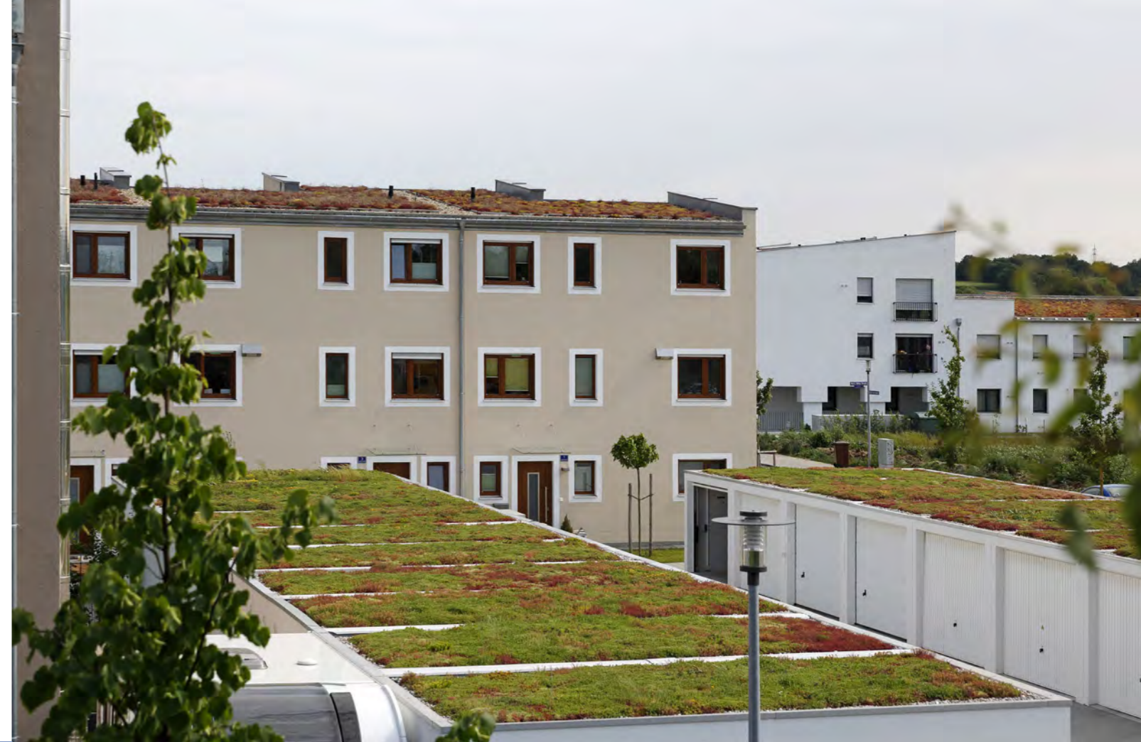
Extensive Schrägdach- (im Hintergrund) und Flachdachbegrünung (im Vordergrund). Quelle: Stadt Regensburg, Bilddokumentation
